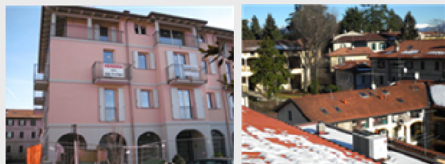
Polo di servizi - vista esterna e dal tetto
