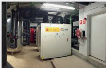
Recinto Modernista San Pau - Vista interna e centrale termica con pompe di calore
